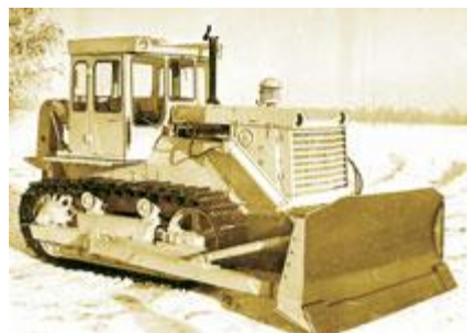
Тракторы Т-170 и бульдозеры Б-170 производились на ЧТЗ в период с 1988 по 2002 года
